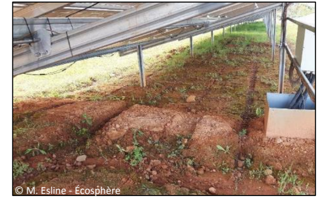
© M. Esline - Écosphère Illustration de l'effet "splash" sous les rainures
