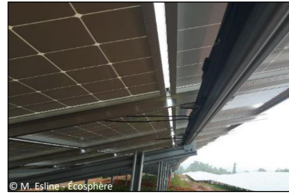
© M. Esline - Écosphère Illustration des rainures permettant à l'eau de s'écouler
